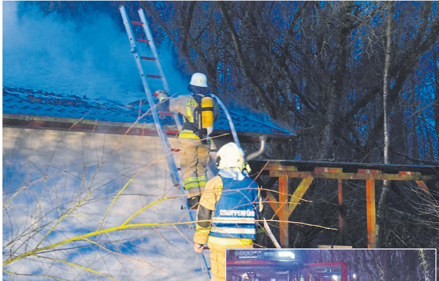
Feuerwehrleute löschen das brennende Zwischendach.
